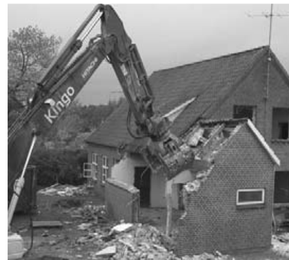
Billeder fra nedrivningen af Fælleshuset.
